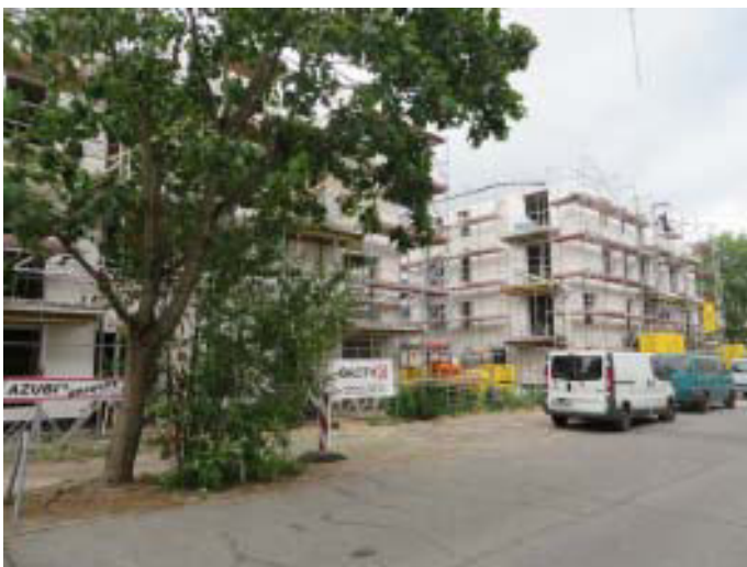
Die Bauarbeiten in der Rolandstraße gehen zügig voran. Ein Richtfest hat bereits stattgefunden
